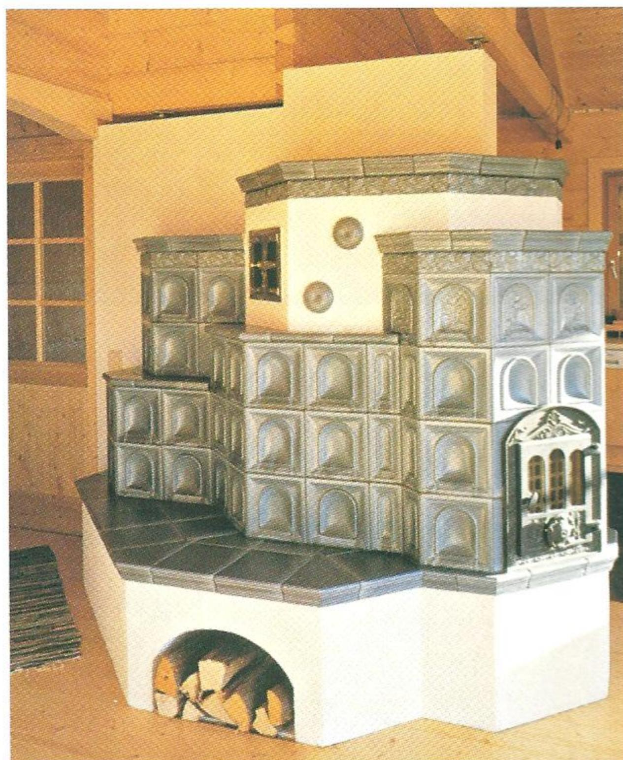
Kachľová pec vďaka vysokej spaľovacej teplote produkuje veľmi malé množstvo popola – zo 100 kg spáleného dreva vznikne len 1 % popola, teda 1 kg. Podmienkou takejto efektívnosti je minimálna hmotnosť pece 800 kg a vedenie spalín pomocou „ťahov“ telesom pece, kde odovzdávajú teplo stenám.
